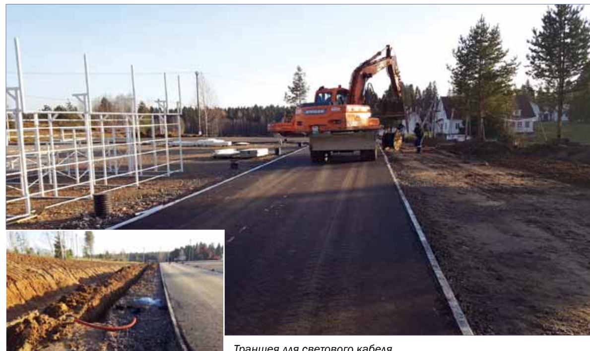
Траншея для светового кабеля
