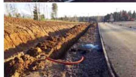
Траншея для светового кабеля
