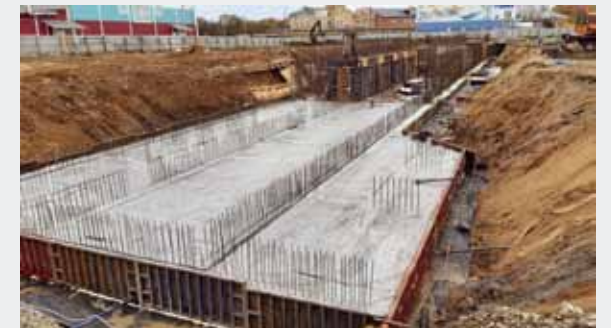
Строительство стадиона в Вологде
