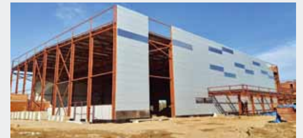
Строительство Ледового Дворца в Вологде
