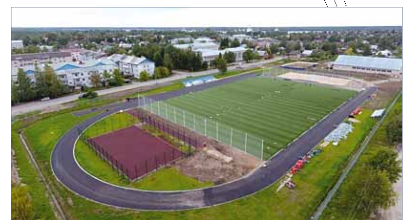
В Кириллове завершился капитальный ремонт стадиона «Чемпион»
