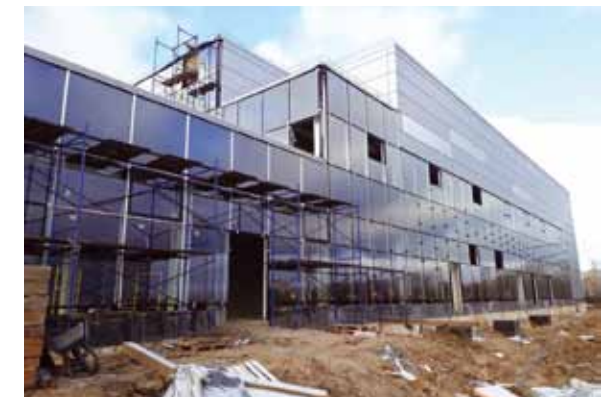
На строящемся в Вологде крытом катке с искусственным льдом завершается монтаж витражного остекления
